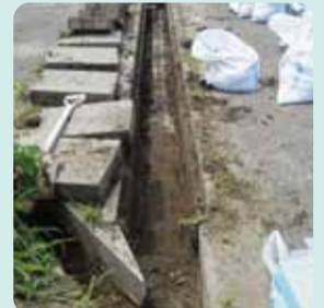
作業後の泥出し
