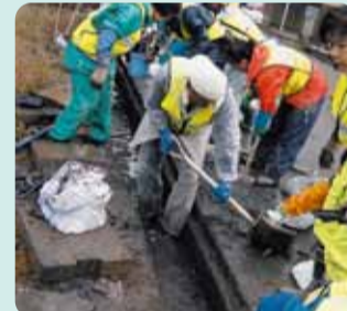
側溝の泥出し②
