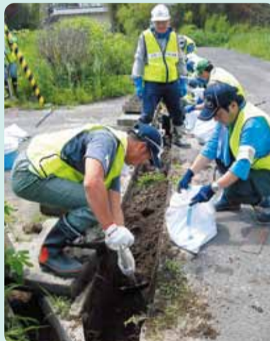
側溝の泥出し①
